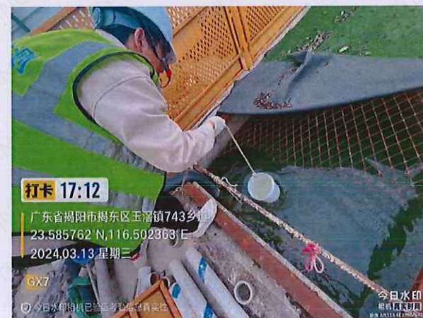
施工 2 标 GX7 生产废水
