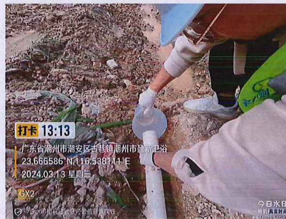
施工 3 标 GX2 厨房生活污水
