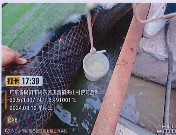
施工 2 标 GX8 生产废水
