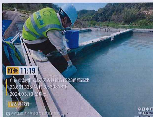
施工 1 标 1#支洞隧道洞口排水
