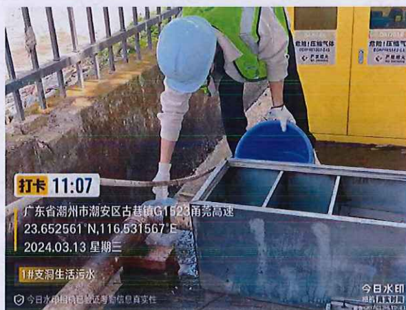
施工 1 标 1#支洞厨房生活污水
