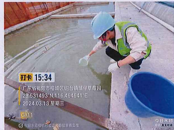
施工 2 标 GX11 生产废水
