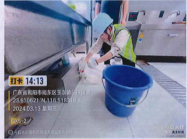
施工 3 标 GX5 厨房生活污水（2 号点）
