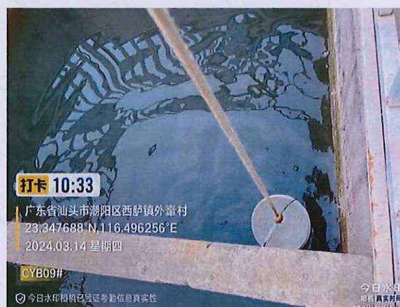
施工 5 标 CYB09#生产废水
