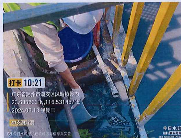
施工 1 标 2#支洞隧道洞口排水
