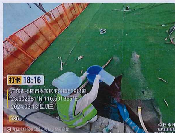
施工 2 标 GX6 生产废水
