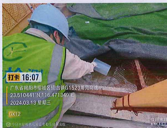
施工 2 标 GX12 生产废水
