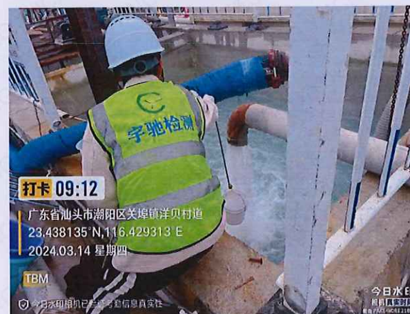
施工 5 标 TBM 隧道开端洞口排水
