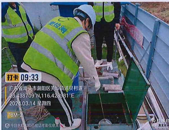
施工 5 标 TBM 隧道开端生活污水
