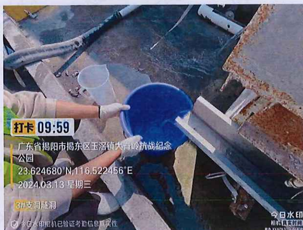
施工 1 标 3#支洞隧道洞口排水
