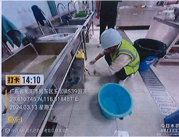
施工 3 标 GX5 厨房生活污水（1 号点）
