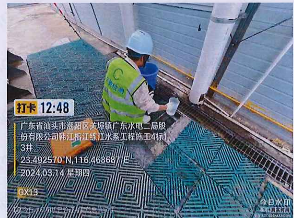
施工 4 标 GX13 厨房生活污水
