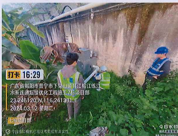
施工七标项目部厨房生活污水
