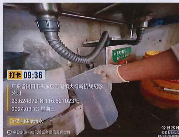
施工 1 标 3#支洞厨房生活污水
